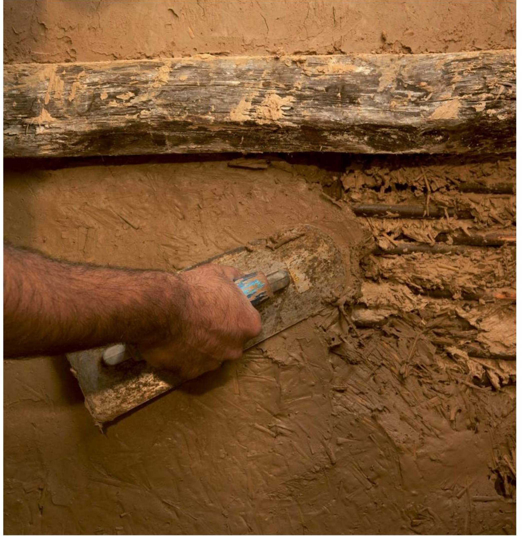
Openluchtmuseum Bokrijk restaureert alle gebouwen in het museum. Hier past een vakman de techniek toe van traditioneel leemwerk met gekapt stro op het woonhuis Kortessem. © Philippe Vangelooven
